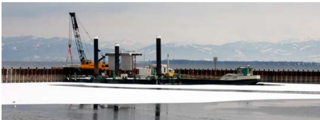
Die Spundwand, unten mit Betonelementen..
