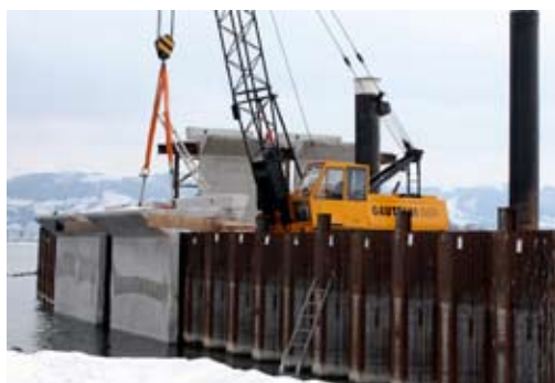
Die Spundwand, unten mit Betonelementen..
